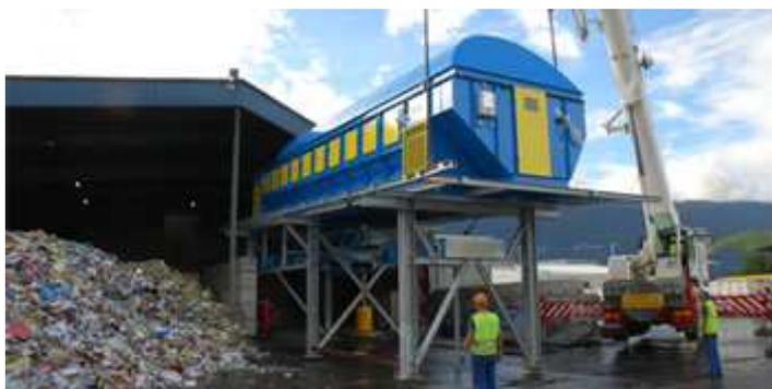
Les emballages sont acheminés jusqu'au centre de tri VALESPACE, situé dans la zone de Bissy à Chambéry (73). Le centre est opérationnel depuis janvier 1995 et des travaux de modernisation ont été réalisés au mois d'octobre 2012 (nouvelle cabine de tri, nouveau trommel\* permettant une séparation granulométrique en trois flux, aménagement pour la sécurité et l'amélioration de la manutention)
